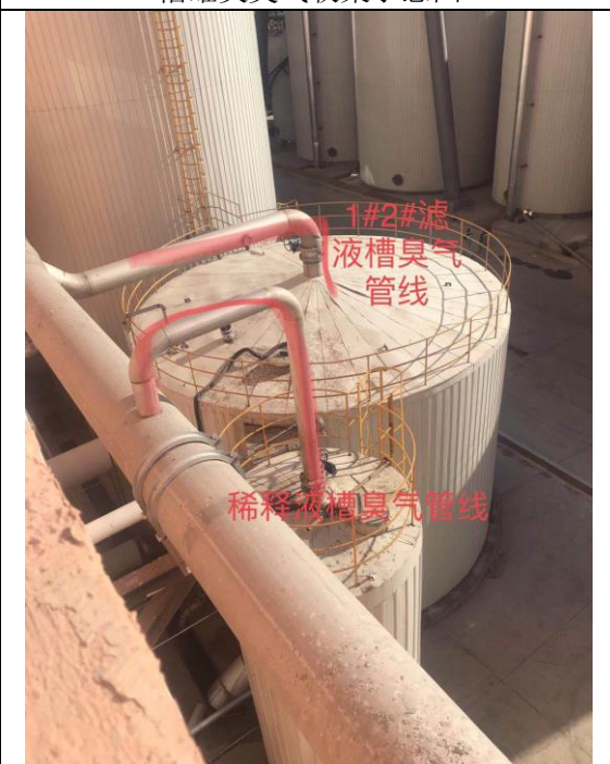
槽罐类臭气收集示意图
