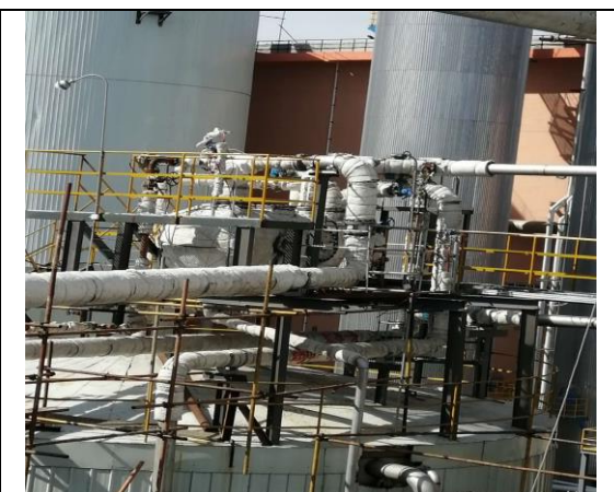
槽罐类臭气收集示意图
