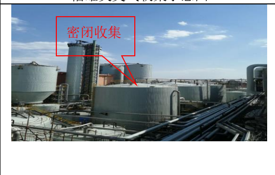
槽罐类臭气收集示意图——蒸发
