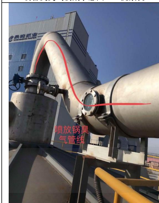
槽罐类臭气收集示意图-喷放锅
