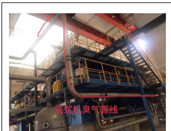
设备类臭气收集示意图——洗浆机
